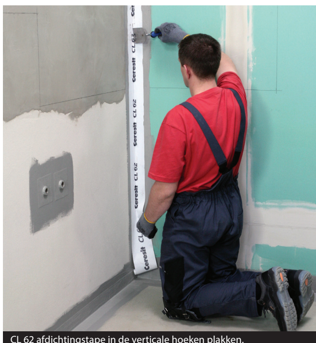
CL 62 afdichtingstape in de verticale hoeken plakken.
