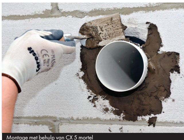
Montage met behulp van CX 5 mortel
