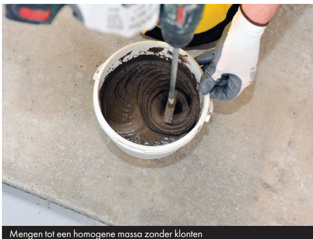
Mengen tot een homogene massa zonder klonten
