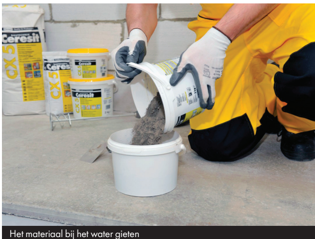
Het materiaal bij het water gieten
