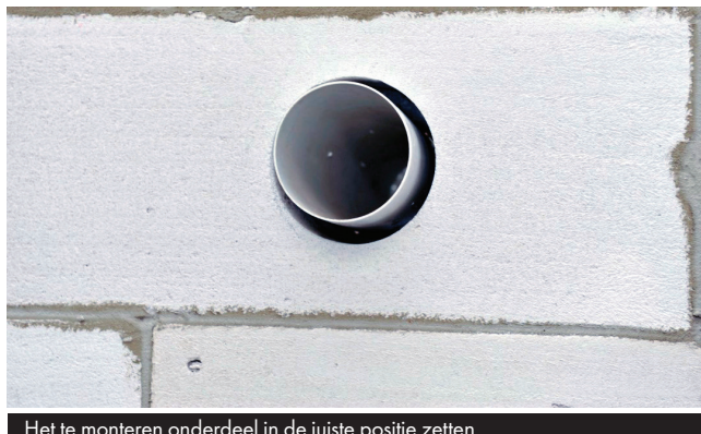
Het te monteren onderdeel in de juiste positie zetten
