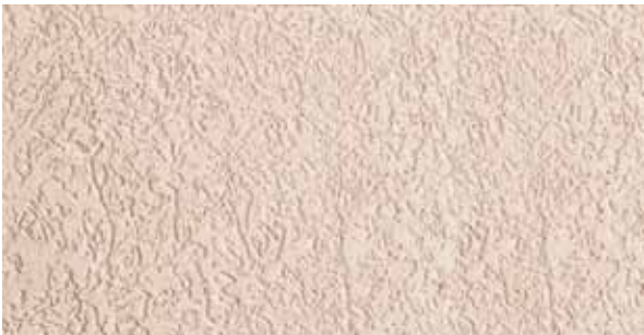
Texture rustique réalisée avec Ceresit CT35 enduit minéral, la taille des grains 2,5 mm, obtenue par mouvements circulaires avec une taloche en plastique
