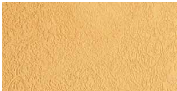
Texture rustique réalisée avec Ceresit CT64 enduit acrylique, la taille des grains 2,0 mm, obtenue par mouvements circulaires avec une taloche en plastique
